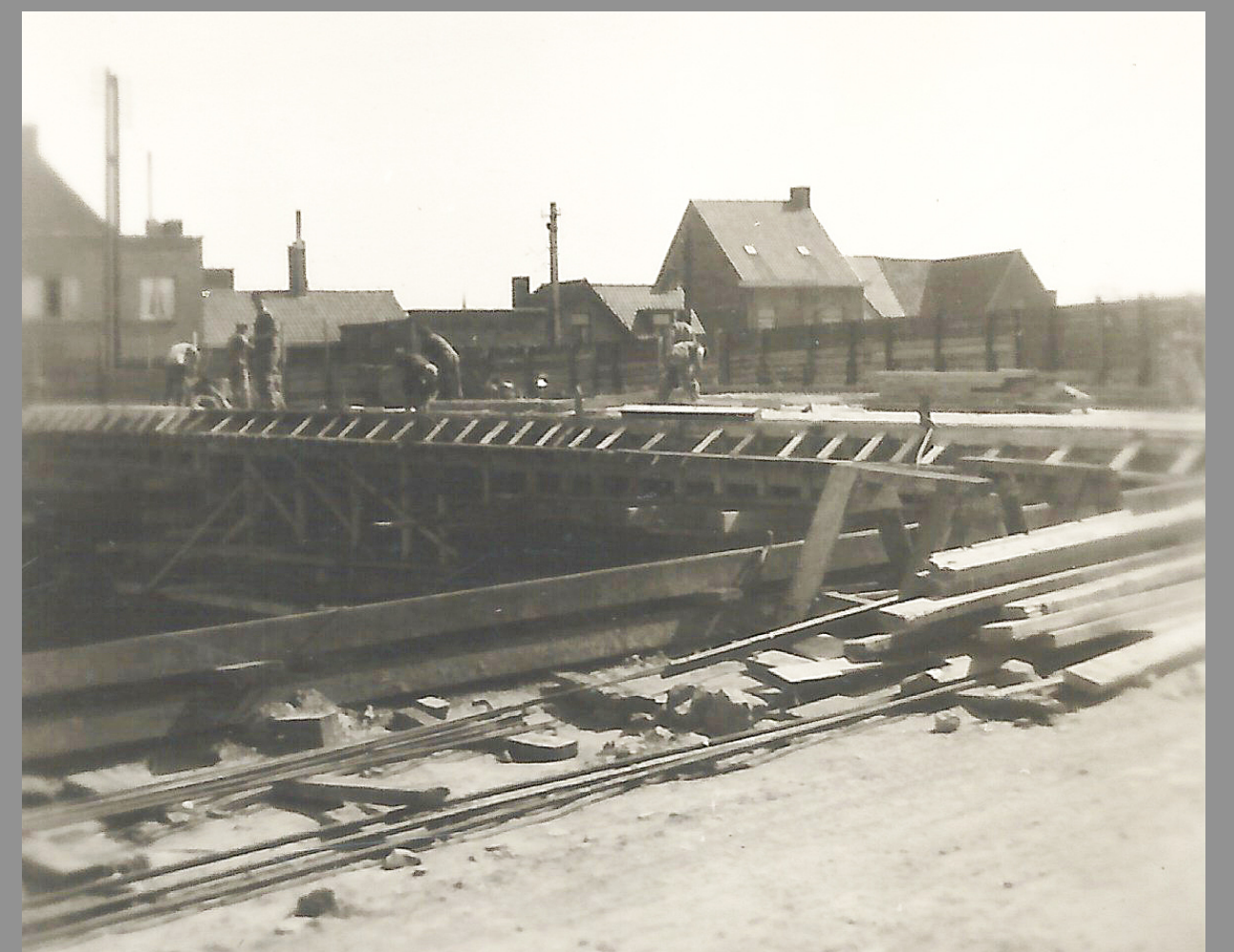
Werken aan de brug over het Schipdonkkanaal in Nevele april 1955
