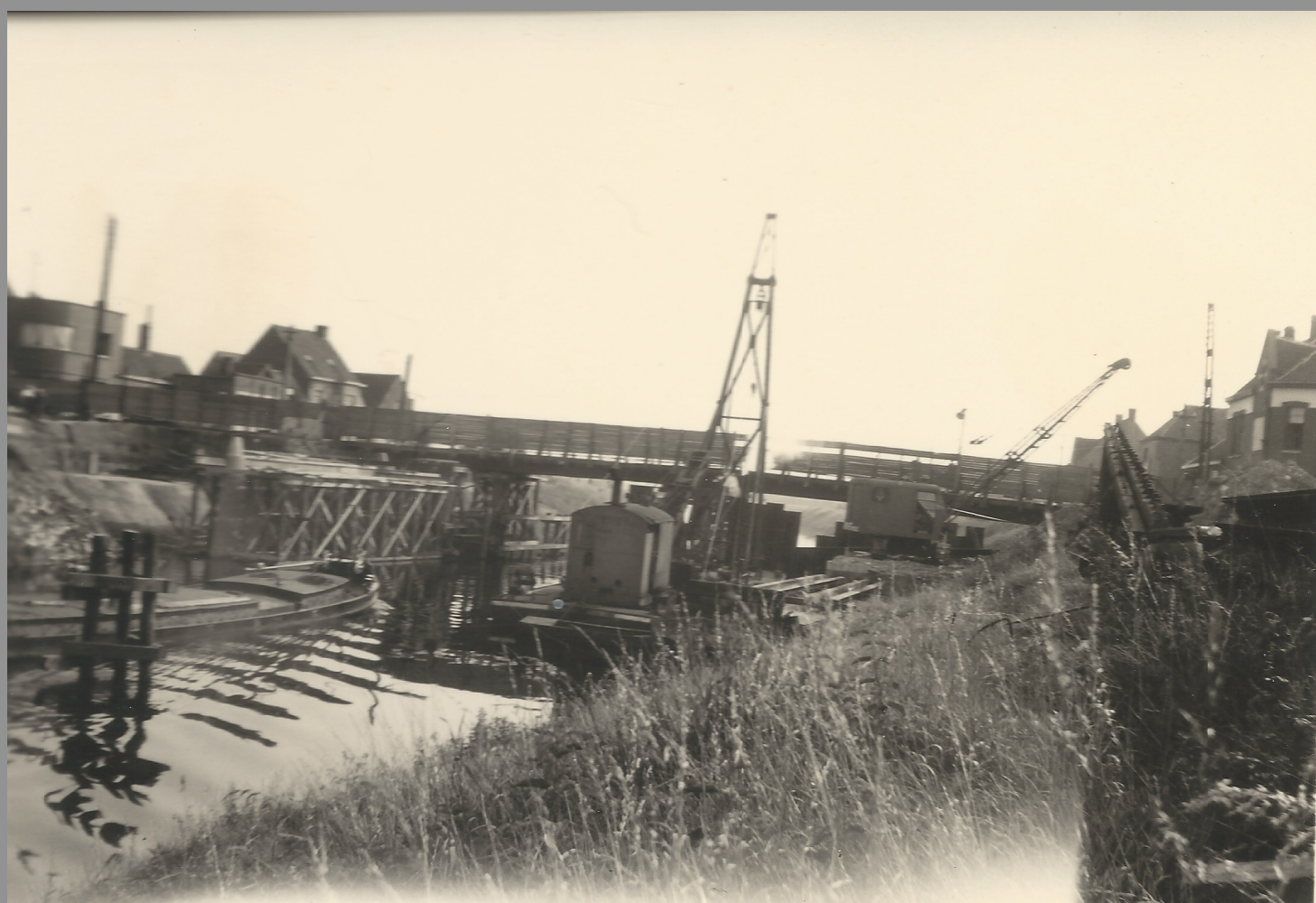
Werken aan de brug over het Schipdonkkanaal in Nevele in september 1954
